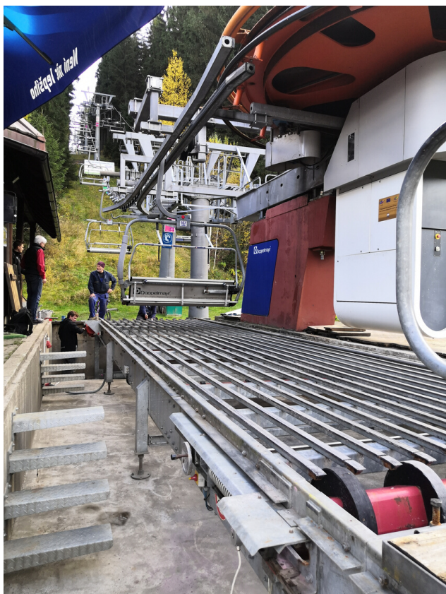
Výměna pojízdného nástupního pásu lanovky
